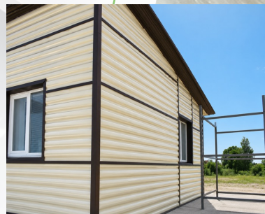
Фасады и стены
